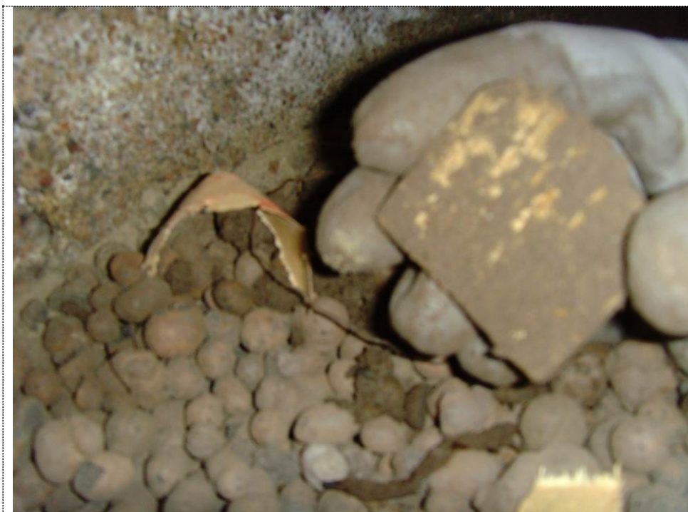
Kuva 18.: Kosteassa kevytsorakerroksessa esiintyy orgaanista ainesta.
