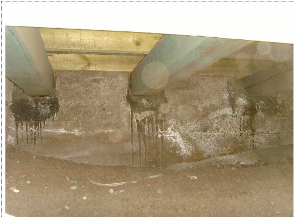
Kuva 11.: Opettajienhuoneen kohdalla alapohjan kannatinhirret on uusittu.
