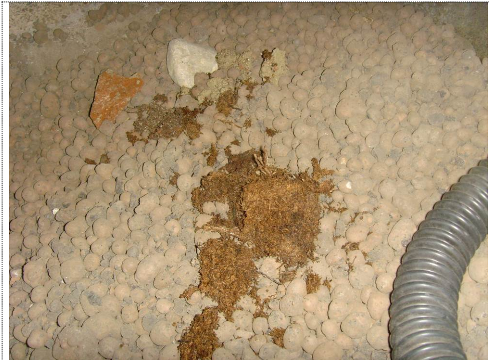
Kuva 19.: Kosteassa kevytsorakerroksessa esiintyy orgaanista ainesta.
