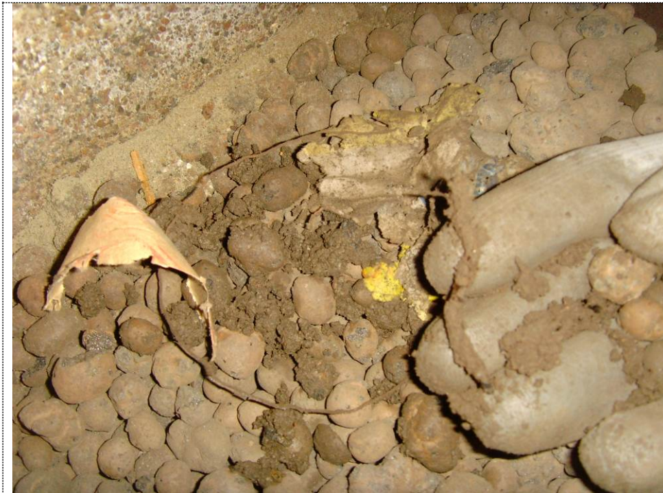
Kuva 17.: Kosteassa kevytsorakerroksessa esiintyy orgaanista ainesta.
