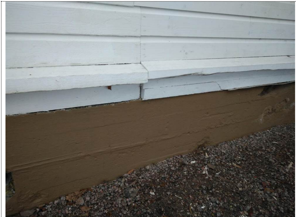
Kuva 4.: Julkisivulaudoitusta ja tippalankkua on uusittu aiemmin.
